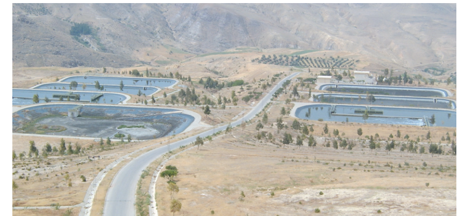
[요르단 폐수처리 시설 확충사업]
