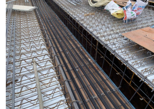
[철근 및 PS강연선 설치]
