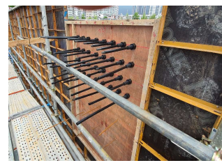
[콘크리트타설 및 양생]
