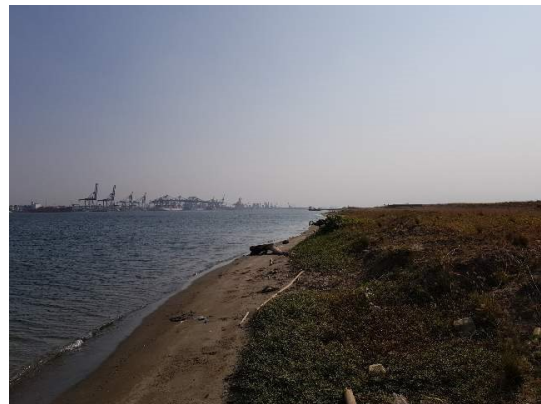
sand bund 유실된 모습
