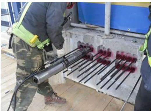
<강연선 긴장(Tensioning) 작업>
