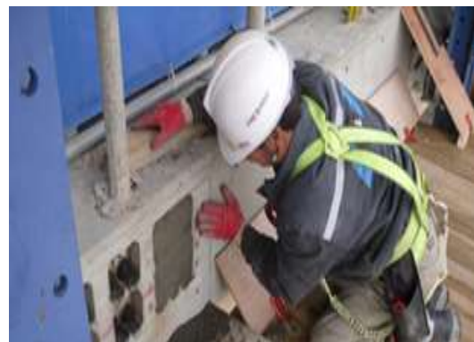
<강연선 절단 후 무수축 몰탈마감>
