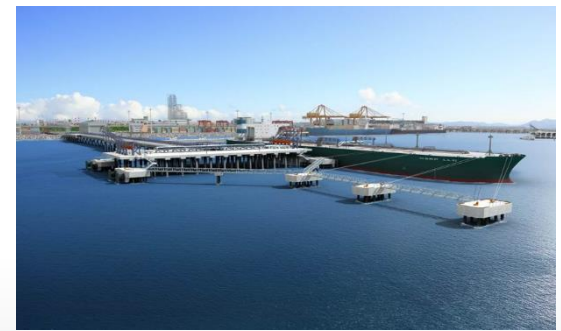
베트남 NSRP 정유공장 해상공사('13)
