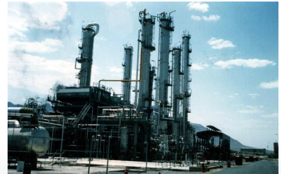
이란 타브리즈 석유화학단지 올레핀 공장('92)
