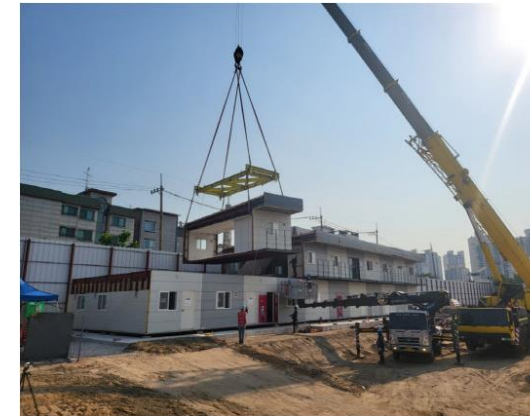
리버센 SK뷰 롯데캐슬 모듈러 사무실 설치 모습. <사진=SK에코플랜트>
